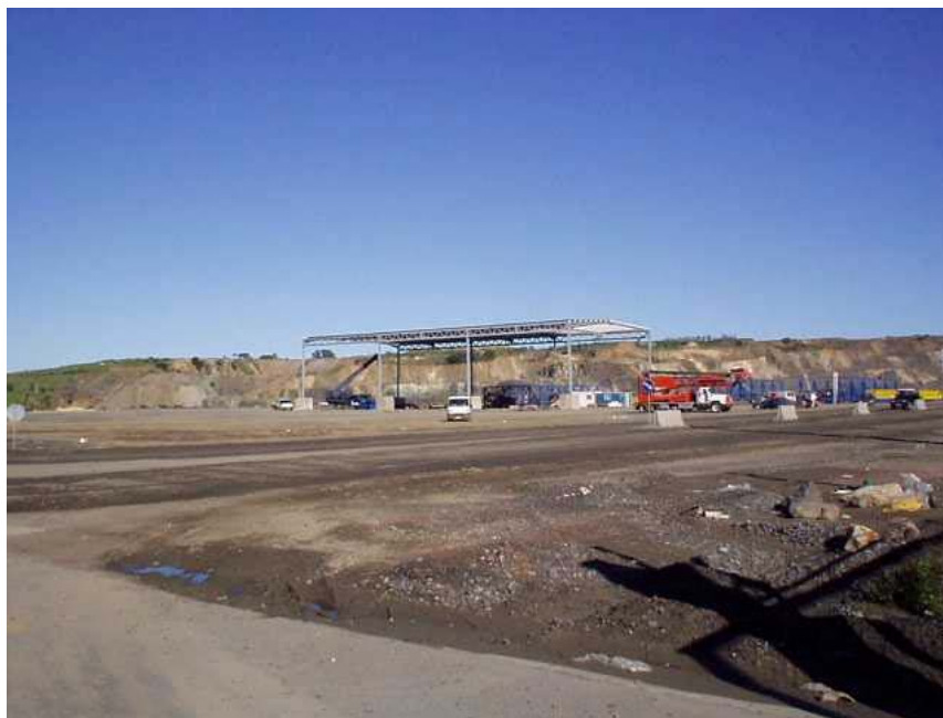
Fotografia 4.1 - Área de implantação do Projecto. Utilização recente como área de apoio à empreitada de Engenharia, fornecimento e construção para o Terminal de gás liquefeito.
